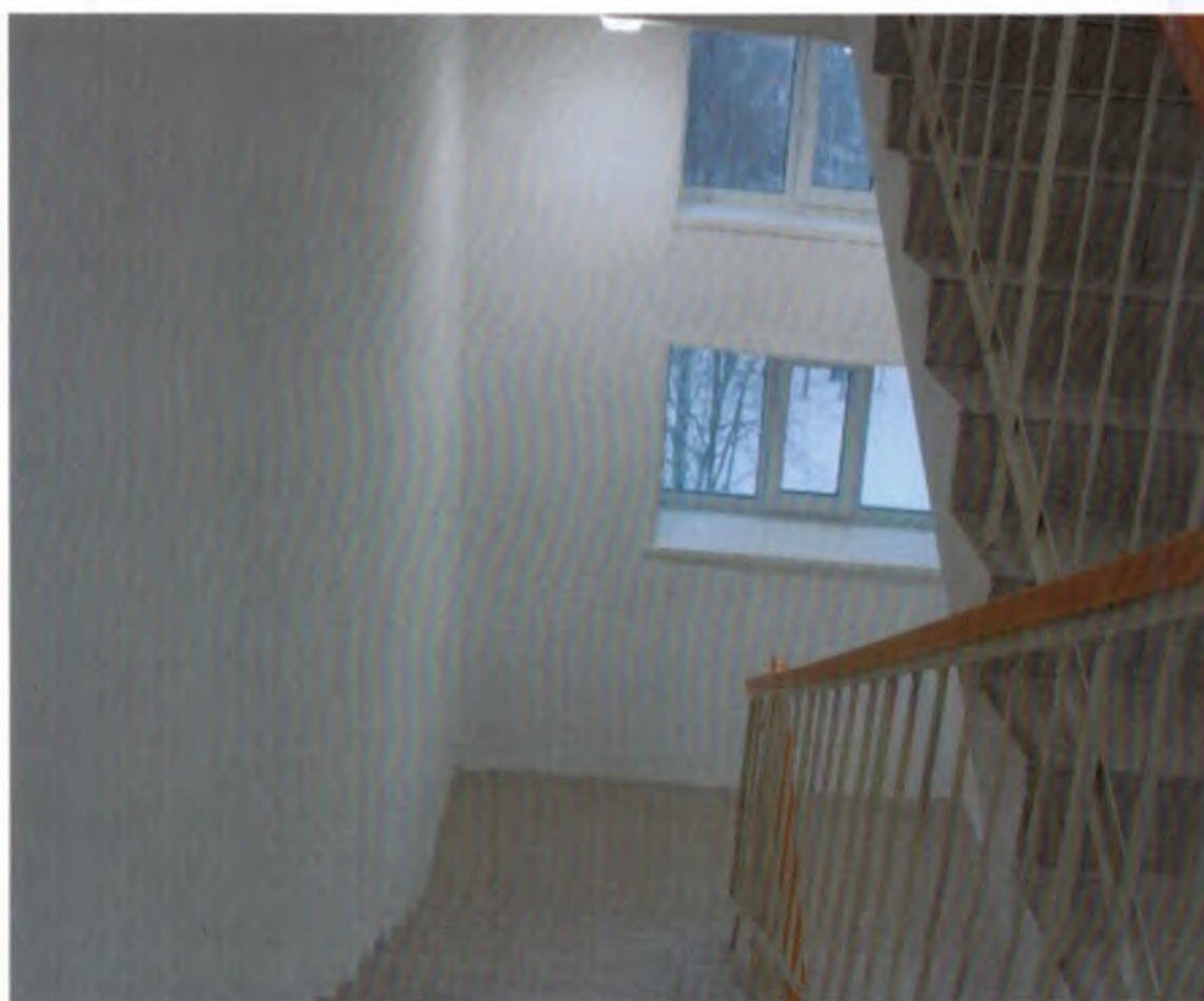
№ 38. Эвакуационная лестница (пролет между 2 и 3 этажами)
