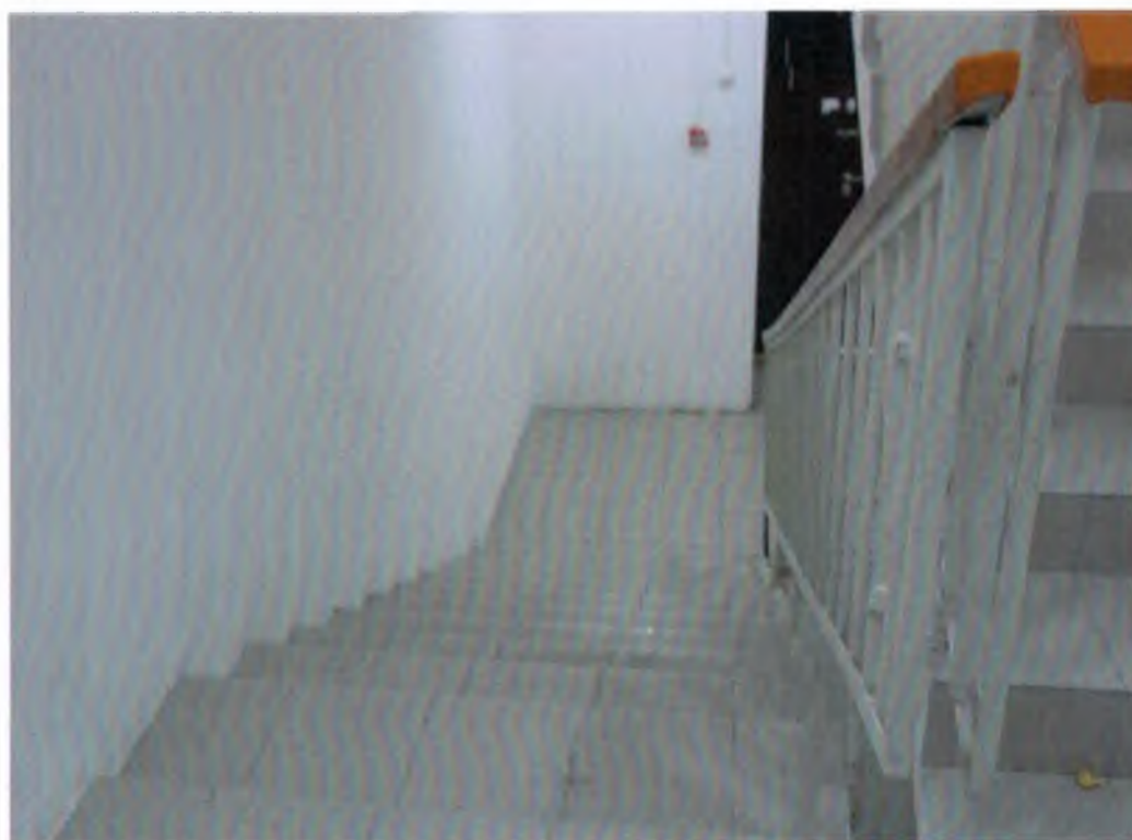
№ 42. Эвакуационная лестница (спуск к запасному выходу, правая сторона)
