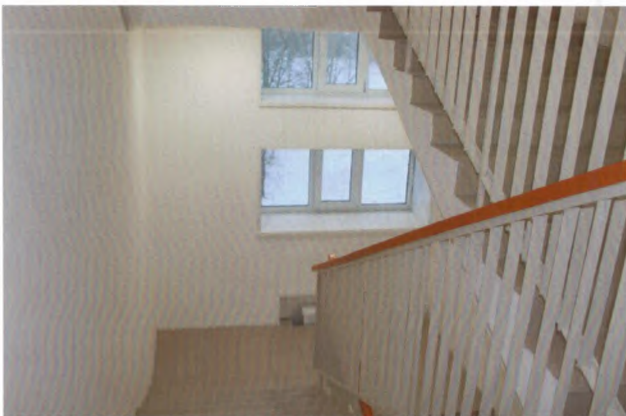
№ 37. Эвакуационная лестница (пролет между 1 и 2 этажами)
