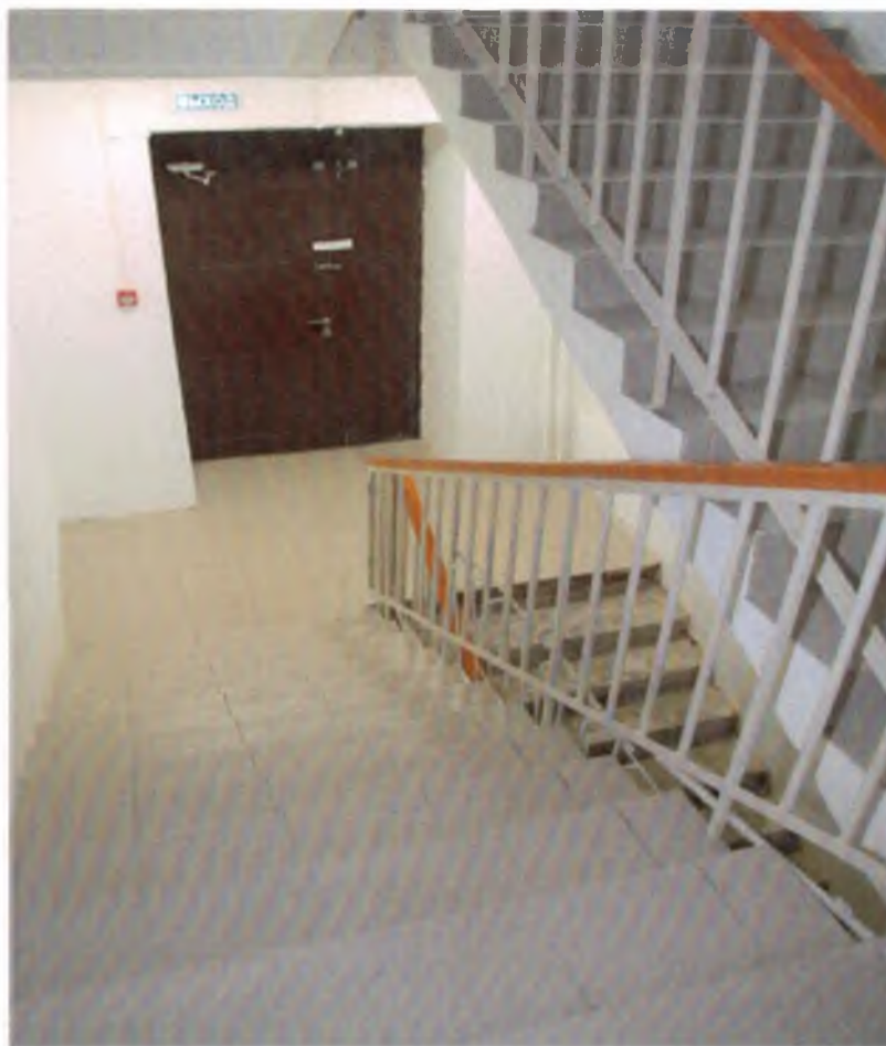
№ 41. Эвакуационная лестница (спуск к запасному выходу, левая сторона)
