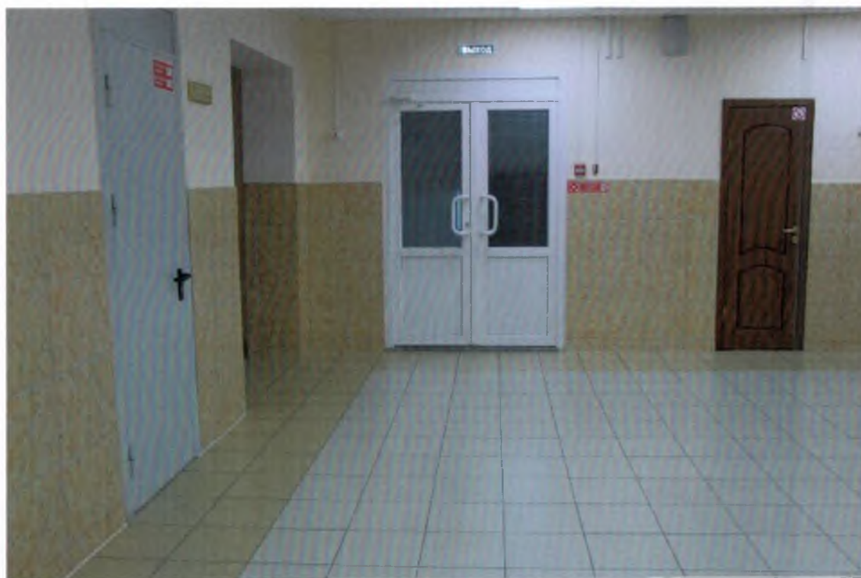
№ 28. Дверь (на 2 этаже запасный выход)
