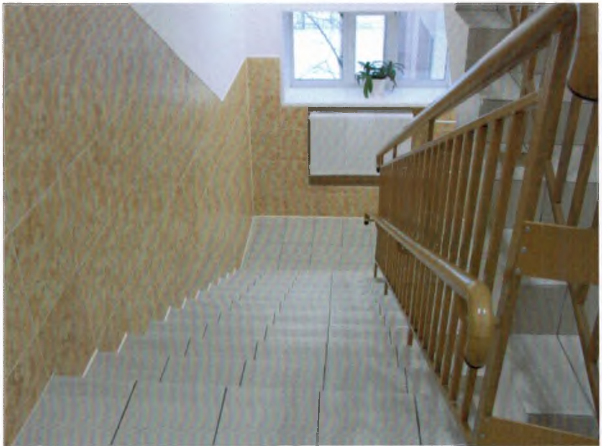
№ 22. Лестница внутри здания (с 3-го на 2-ой этаж)
