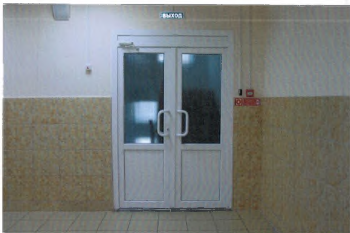
№ 29. Дверь (на 3 этаже запасный выход)
