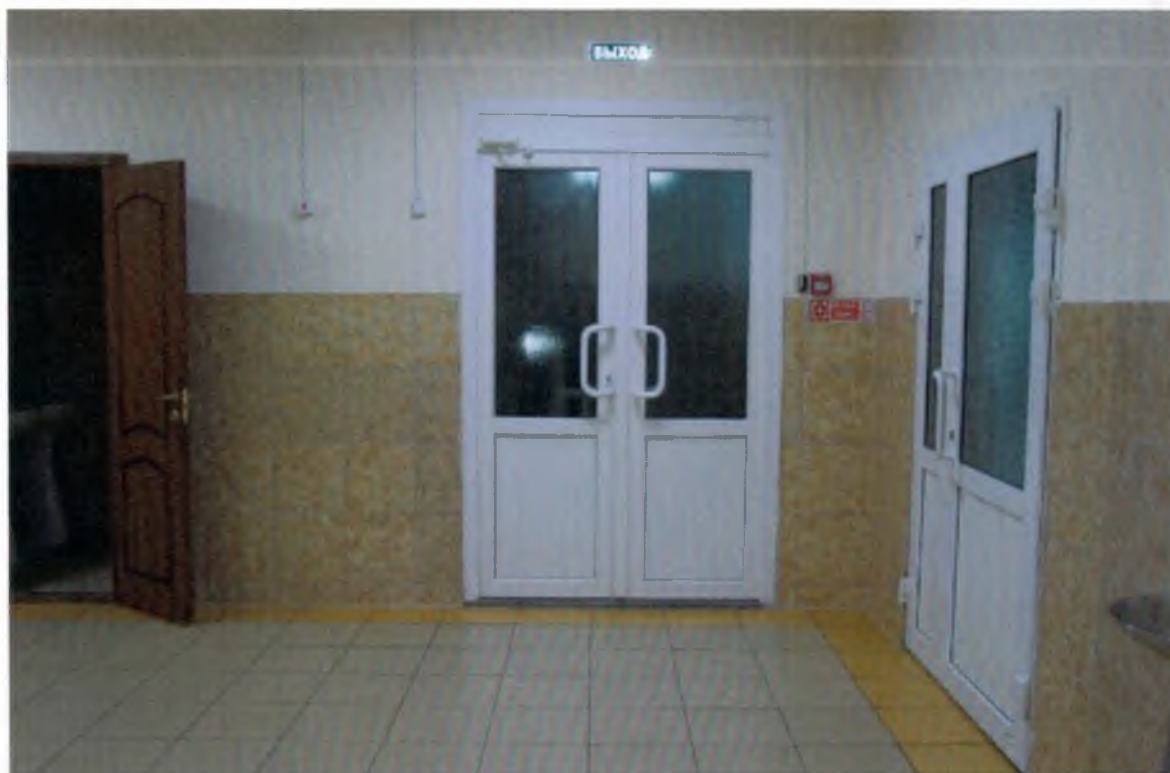
№ 27. Дверь (на 1 этаже запасный выход)
