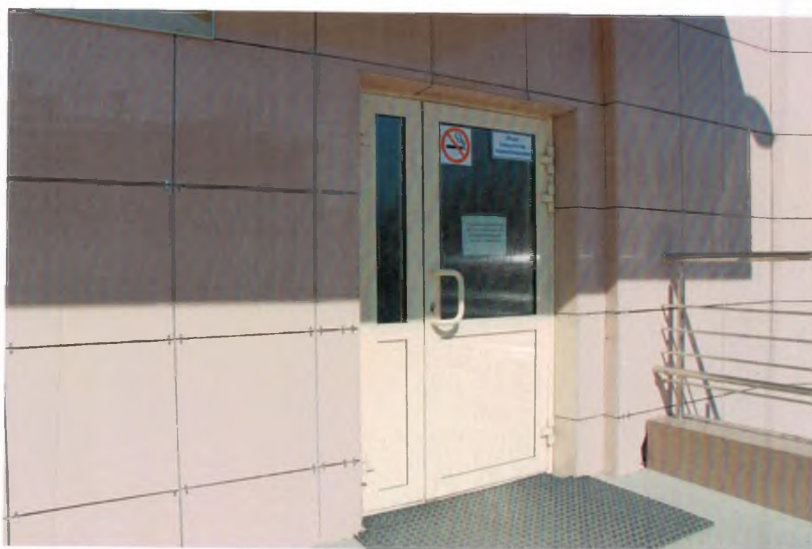
№ 10. Входная дверь (центральный вход)
