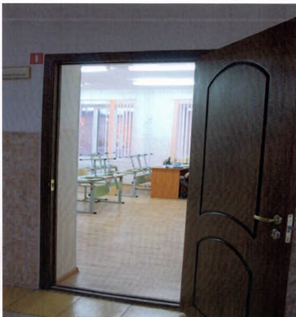
№ 43. Зона целевого назначения (кабинет 1 этаж)
