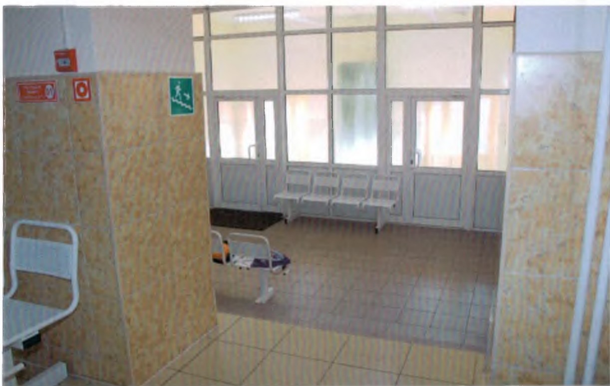
№ 36. Путь эвакуации (центральный вход)
